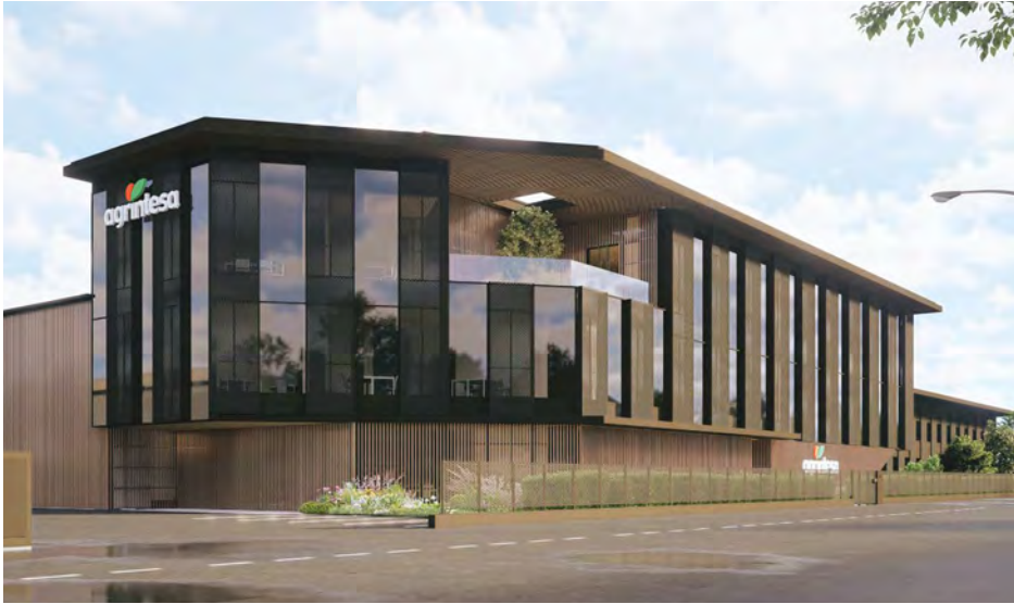
Come si presenterà la sede Agrintesa di Faenza al termine dei lavori di ristrutturazione
